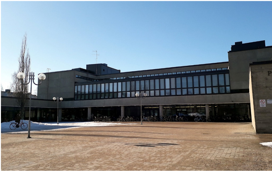
Pohjankartano, massiivinen betonikompleksi ja Madetojan musiikkilukion koti
