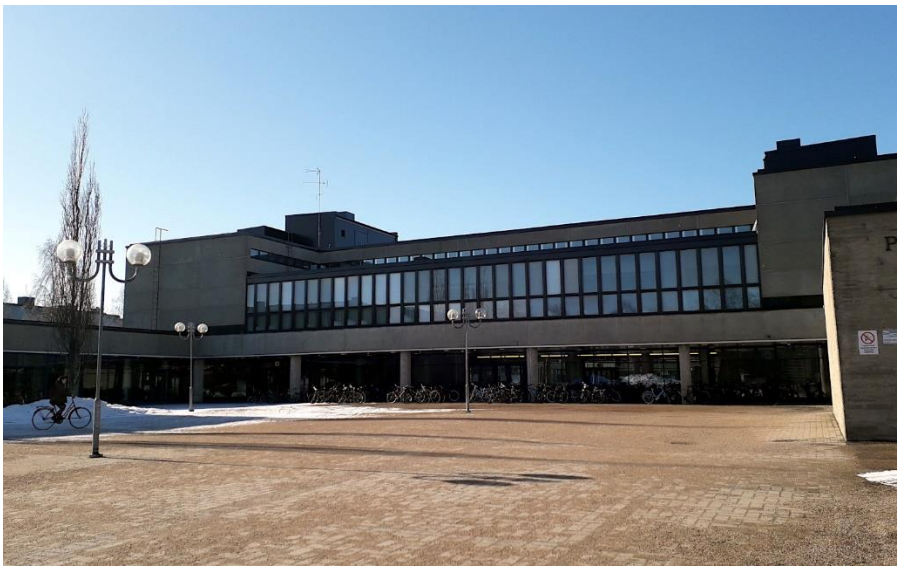
Pohjankartano, massiivinen betonikompleksi ja Madetojan musiikkilukion koti
